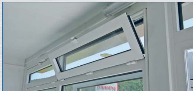
Верхня стулка – за замовленням з важелем відкриття
